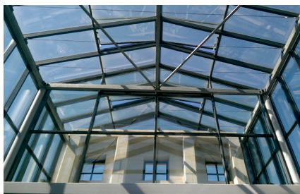
Illustration 5 : verrière en toiture.
