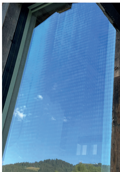
Illustration 18 : traces brunes créées par le phénomène d'anisotropie.
