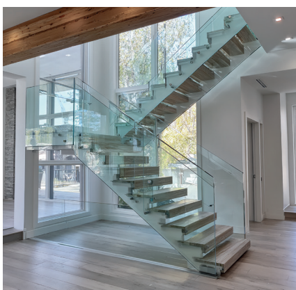
Illustration 6 : escalier en verre structurel.
